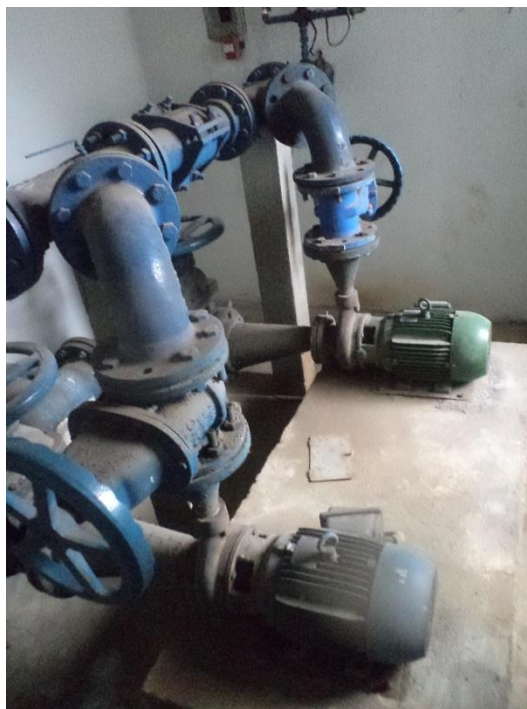
Foto 5.21 – Estação Elevatória de Água Tratada
