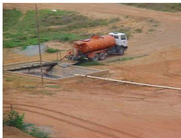
Foto 5.34 – Caixa Coletora do Chorume
