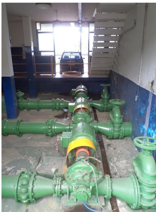
Foto 5.8 – Recalque da água tratada – ETA para R1
