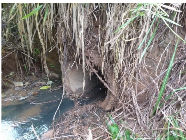
Foto 5.51 – Ponto 09 - Possível tubulação subdimensionada
