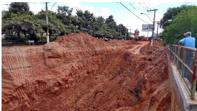
Foto 5.65 – Cratera formada pelo desmoronamento – Av. Acesita
