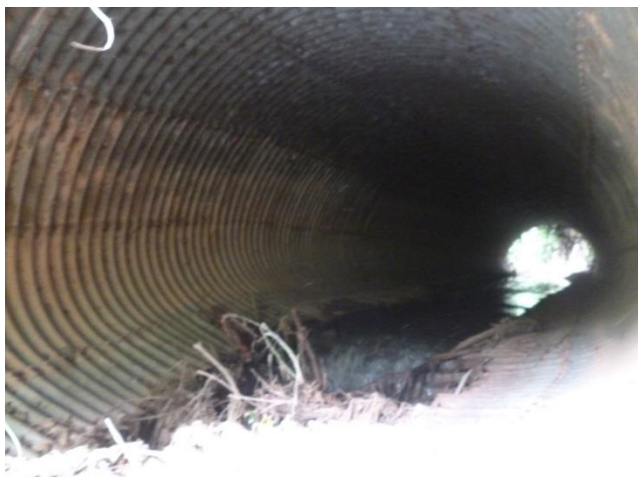
Foto 5.55 – Ponto 14 - As chapas de aço da base do bueiro encontram-se desgastadas, enferrujadas e soltas - Córrego Alegre
