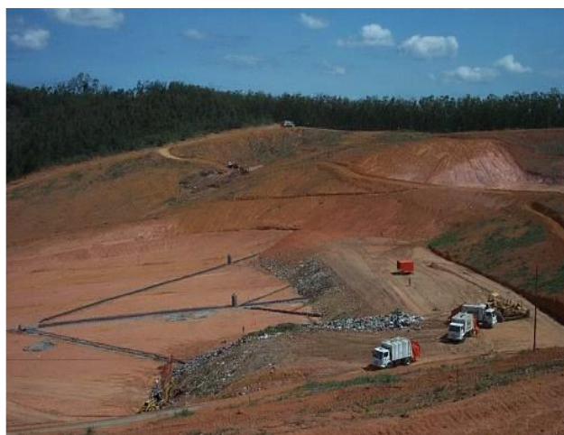
Foto 5.30 – Vista do Aterro – Área de Disposição Com Drenos de Chorume
